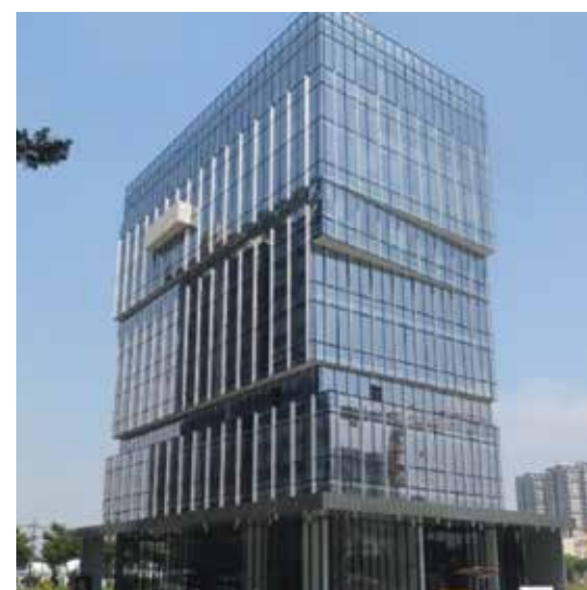
Công trình M-Building
