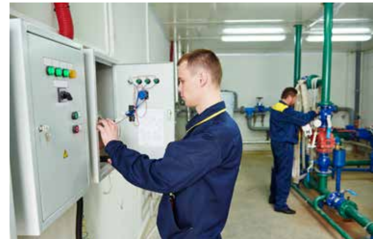
H Ì N H . 3 9 Một buồng điện thông thường của công trình
